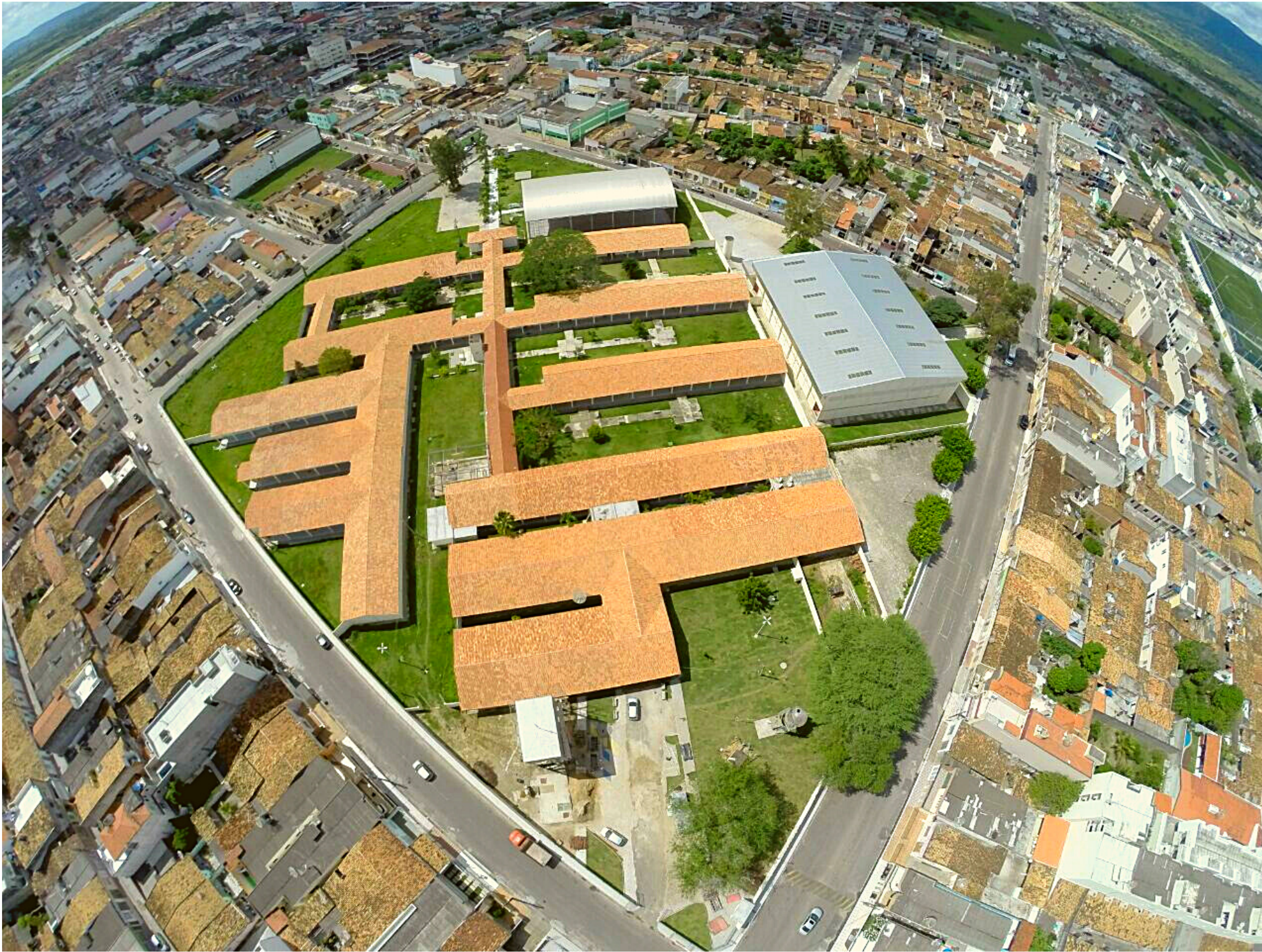
Reforma da Escola Murilo Braga
